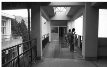
渡り廊下もバリアフリーです
