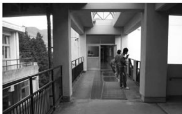
渡り廊下もバリアフリーです
