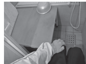
浴室に洗体台を設置 扉は引き戸に変更
