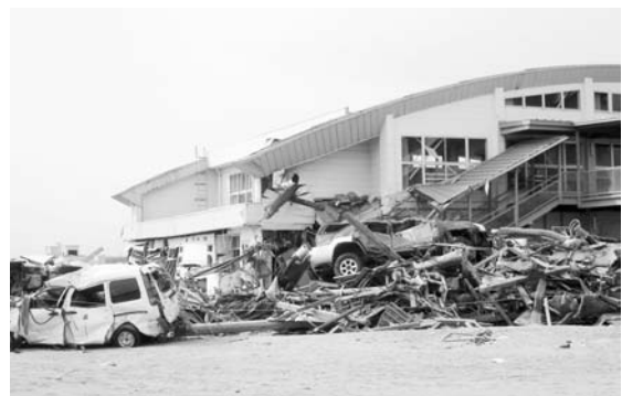
押しつぶされた体育館
